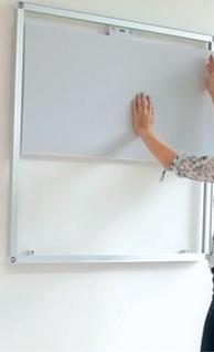
Den Schallabsorber unterhalb der Aufhängung einpassen und die geplante Schnittkante markieren.
